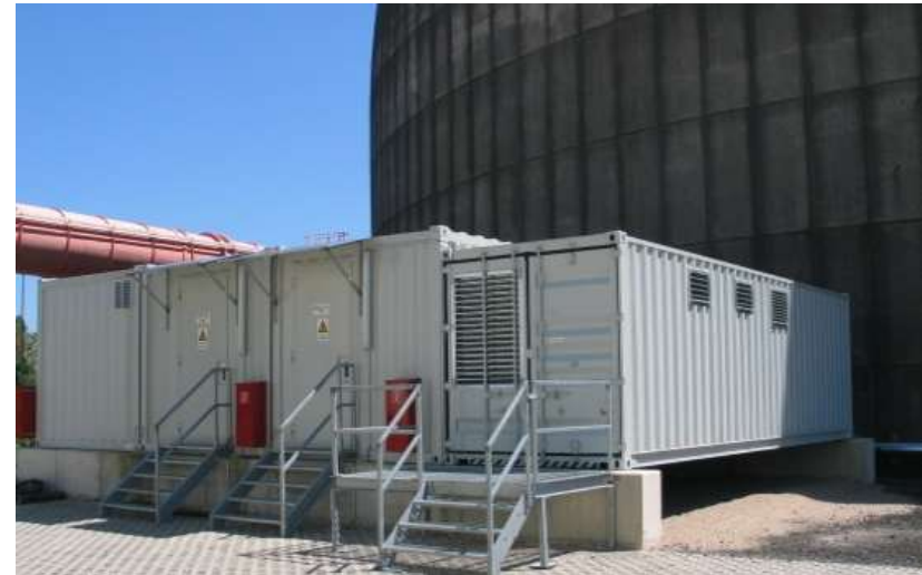
Angepasste Schaltanlage im Rückbau
