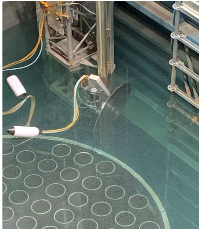
Kalttrennanlage zerlegt Tragwerkszylinder
