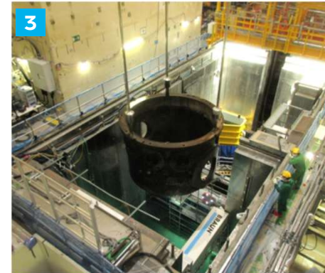
3 Zerlegung der RDB-Einbauten in Mülheim-Kärlich
