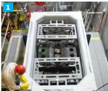
1 RDG-Deckel in Lingen erfolgreich zerlegt und fachgerecht verpackt
